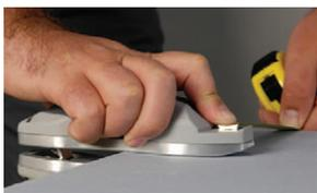
Assicurarsi che la linea di incisione sia esattamente sul bordo della pila di lastre in gesso rivestito. Far leva delicatamente sull'angolo mentre lo si allontana dalla pila. Assicurarsi che la pressione non sia eccessiva poiché ciò potrebbe causare tagli poco precisi.
